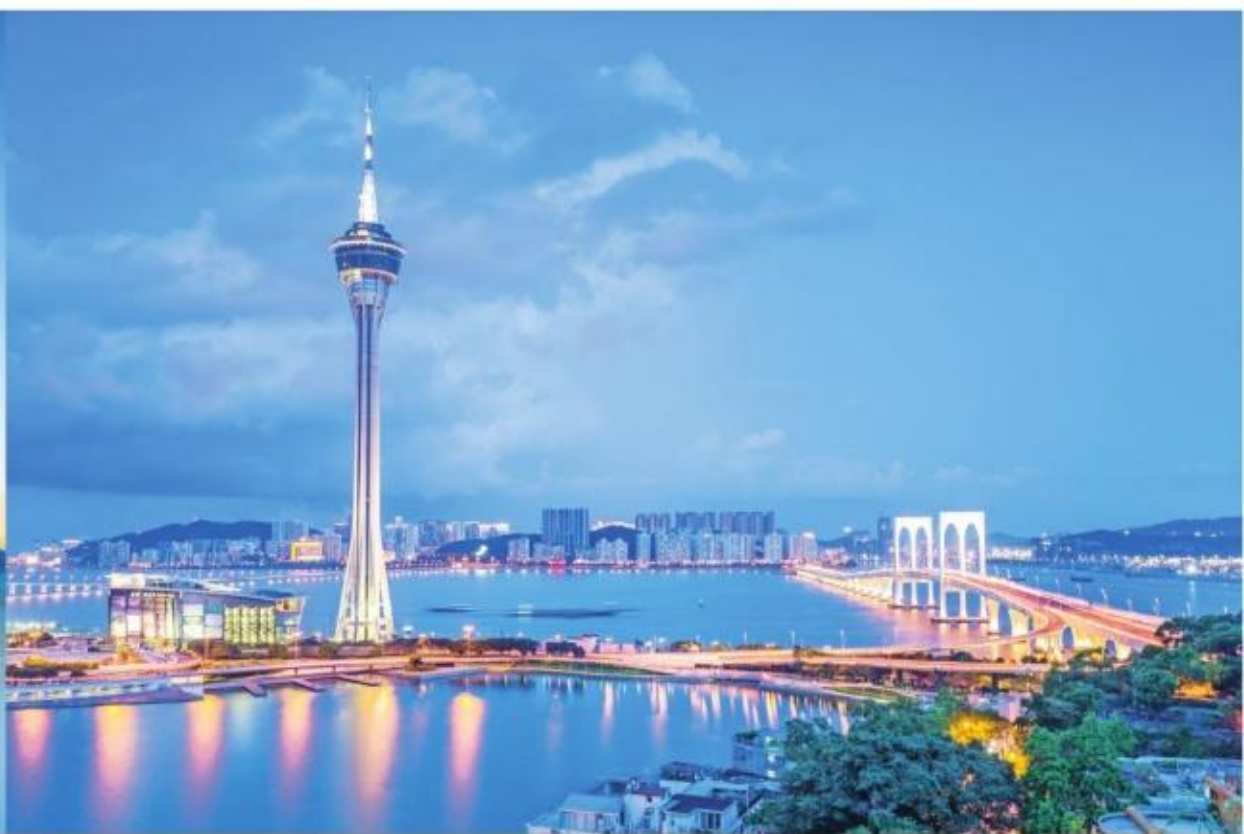
澳门西湾大桥
