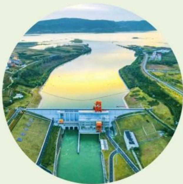
南水北调中线工程渠首大坝
