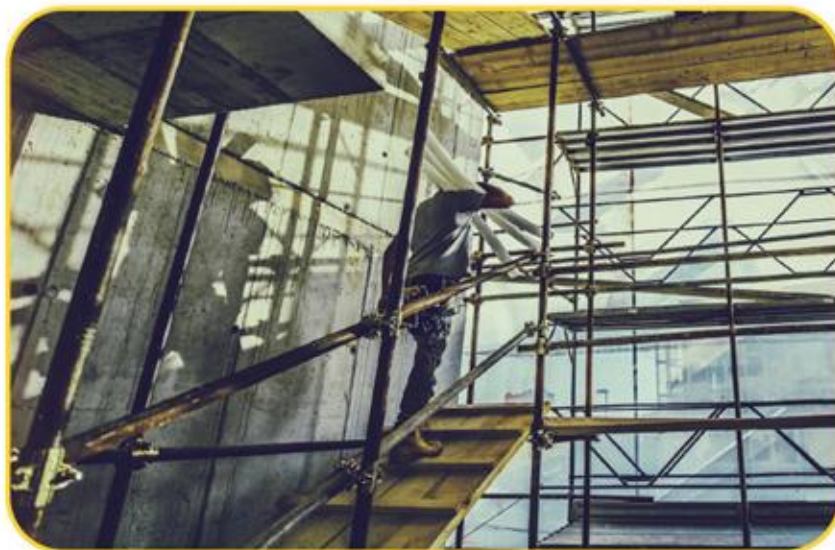
脚手架上的斜面
