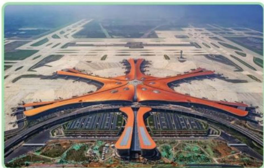
北京大兴国际机场
