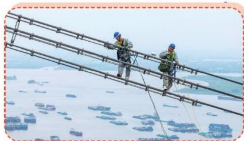
输电线路检修
