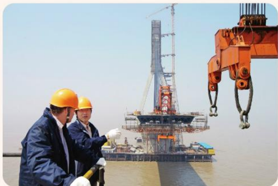
▲ 施工现场，工程人员在观察大桥施工情况。
