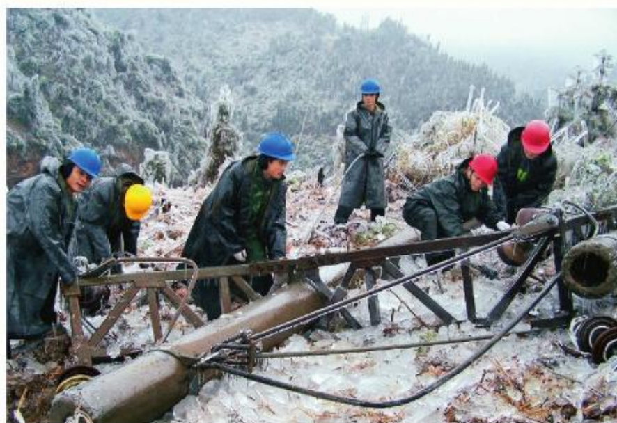
▲ 电力工人在“冰山”上抢修供电设备，为千家万户送去光明。
