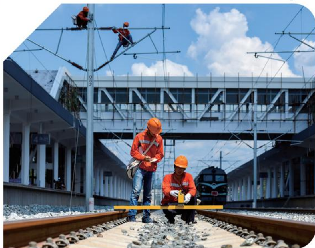
yòng jī guāng cè liáng yí duì zhàn chǎng shè 用激光测量仪对站场设 bèi jìn xíng jīng què cè liáng 备进行精确测量。
